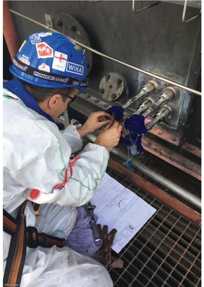
Проверка передачи сигнала и функциональное тестирование
